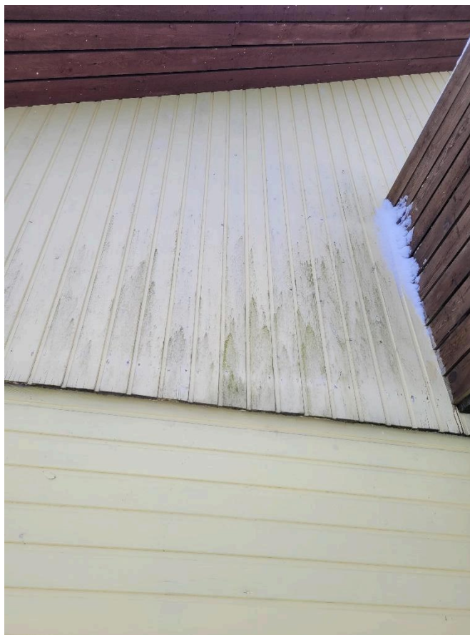
Pilt 5. Niiskuskahjustused läänepoolsel fassaadil
